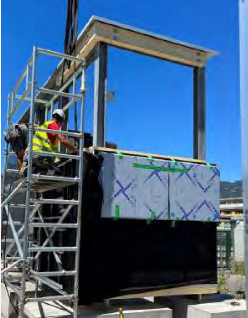
First „floor“ prefab module installation
